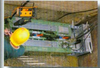
Bild links: Gesteuerte Bohranlage GRUNDODRILL Bild unten: Rohrerneuerung mit GRUNDOBURST
