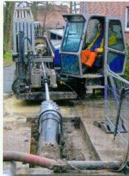
Bild links: Gesteuerte Bohranlage GRUNDODRILL Bild unten: Rohrerneuerung mit GRUNDOBURST
